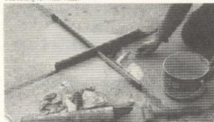
Kantenreparaturen mit ods Durit Mörtel
